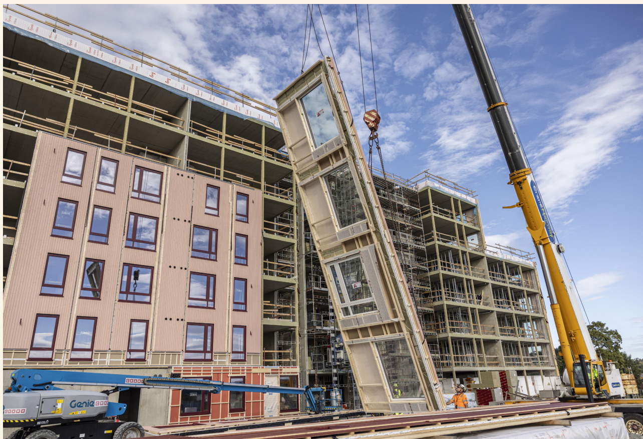
Montasje av elementer fra Ringsaker Vegg- og Takelementer med leveranse fra G3 Gausdal Treindustrier
