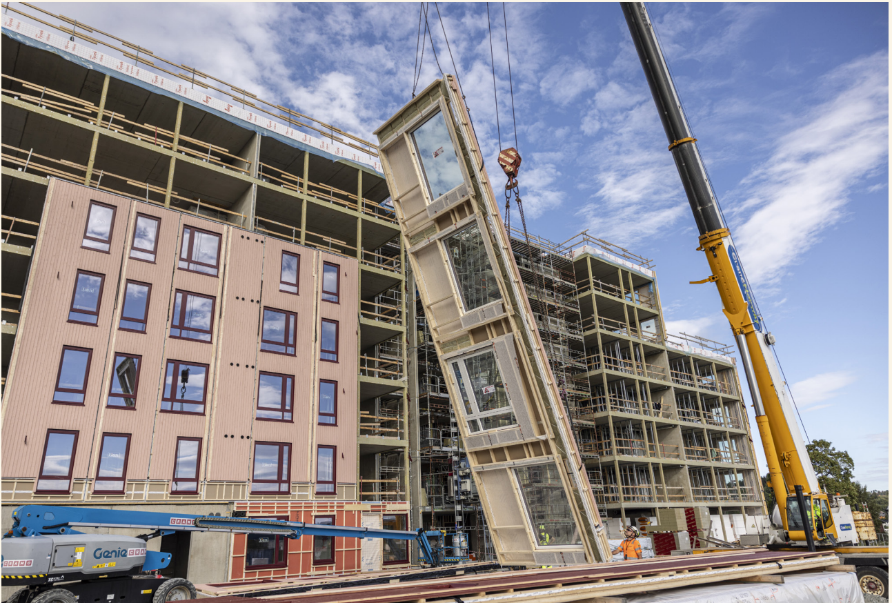
Montasje av elementer fra Ringsaker Vegg- og Takelementer med leveranse fra G3 Gausdal Treindustrier
