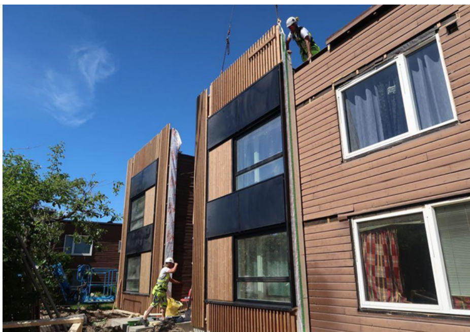
Bilde 2: Nye fasadeelementer på kommunal bolig på Haugerud i Oslo. Prosjekt med SINTEF, Boligbygg og Filter Arkitekter. Foto: tenktre.no
