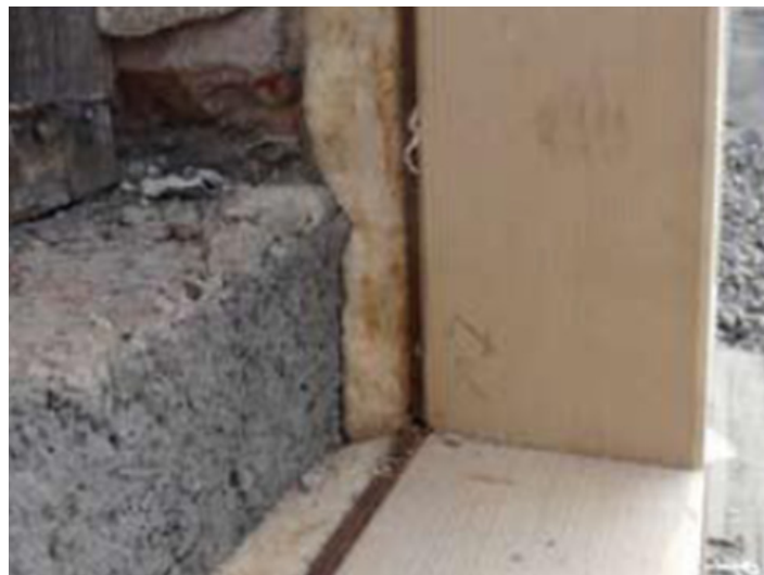
Bilde 3: Utjevningssjikt av isolasjon
